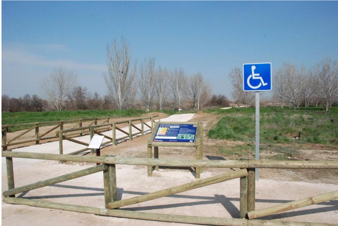
Referencia: Estacionamiento accesible. Sendero Sierra de Madrid
